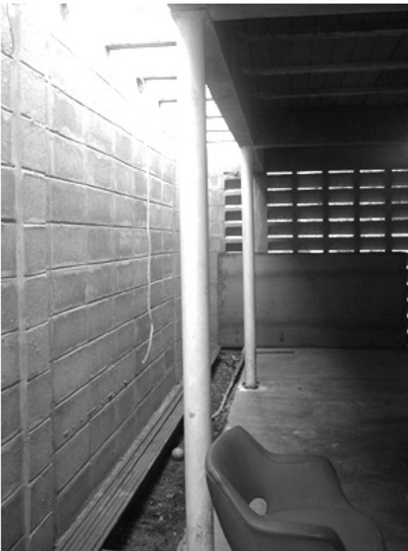
Figura 5: Dispositivo cenital de iluminación y ventilación natural de la VBP-1
